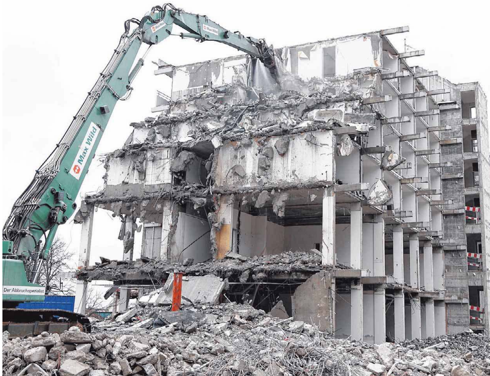
Nach den Abbrucharbeiten des alten Sanatoriums im Jahr 2010 liegen der Stadt Aulendorf nun drei Angebote vor.
